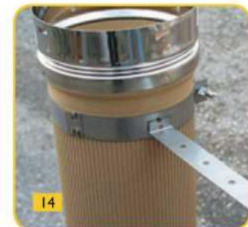
Таким же образом смонтировать требуемое количество профилированных труб (2a/b) до отметки верхней ревизионной дверцы или до устья дымовой трубы (Рисунок 13).
