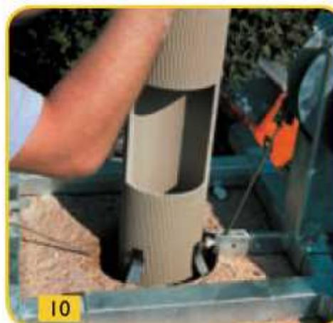
При помощи спусковой лебёдки (W4) опустить профилированную трубу с вырезом (2a/b) в шахту до растрuba (Рисунок 10).
