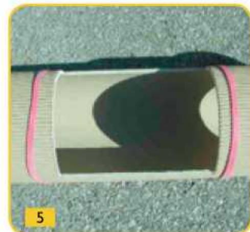
Обтянуть крепёжными резинками (прилагаются к универсальному штуцеру (6a/b) профилированную трубу в месте выреза (над и под ним) (Рисунок 5). Эти резинки предназначены для фиксации универсального штуцера до высыхания герметика.
