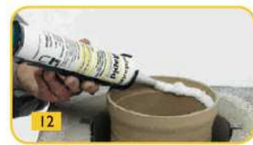
Нанести специальную массу Rapid (8a), или массу FM (8c) для герметизации швов, или массу Rotempo (8b) в растрub профилированной трубы (Рисунок 12).
