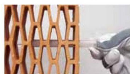
2. Установить в просверленное отверстие соответствующую сетчатую гильзу.
