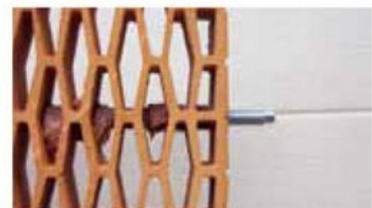
5. Корректировку положения анкера возможно проводить в период схватывания химического состава\*.
