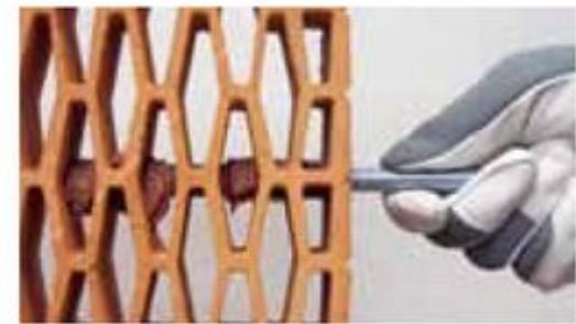
4. Вращательным движением установить металлическую анкерную шпильку в сетчатую гильзу.
