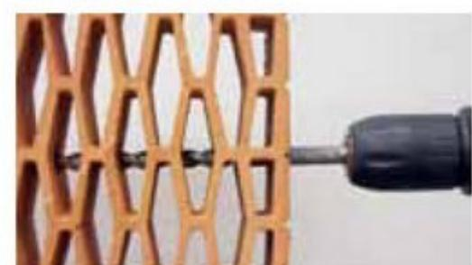
1. Просверлить отверстие требуемого диаметра и глубины, соответствующих выбранному размеру сетчатой гильзы.
