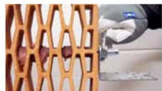
6. После полного отверждения химического состава возможно приложение нагрузки\*.
