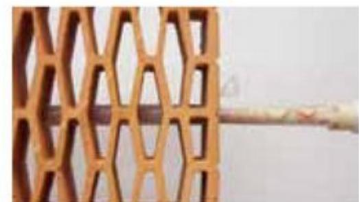
3. Равномерно заполнить весь объем сетчатой гильзы химическим составом.
