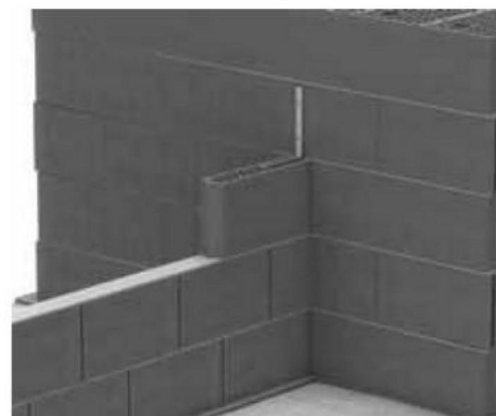
При соединении перегородки с несущей стеной на торцы блоков **Porotherm 8** или **Porotherm 12** нанесите раствор, уложите их и прижмите к несущей стене. При таком типестыка необходимо укреплять каждый второй постельный шов с помощью плоского анкера из нержавеющей стали. Согнутую под прямым углом горизонтальную часть анкера нужно вдавить в раствор постельного шва, а вертикальную часть – прикрутить с помощью шурупа и дюбеля к несущей стене.
