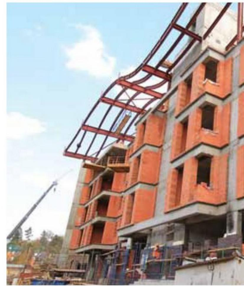
**Малоквартирный дом «Каскад»** в жилом комплексе «Олимпийская деревня Новогорск», построенный по проекту «Архитектуриума» (мастерская Владимира Бинденмана), — оригинальное по архитектуре и применяемым техническим решениям здание, в котором в качестве материала для заполнения монолитного каркаса применялись блоки Porotherm 44 без дополнительного утепления.
